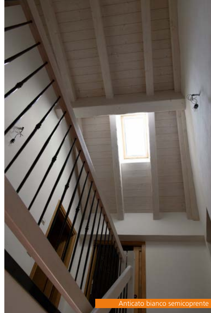
Lamellare con travi boomerang
